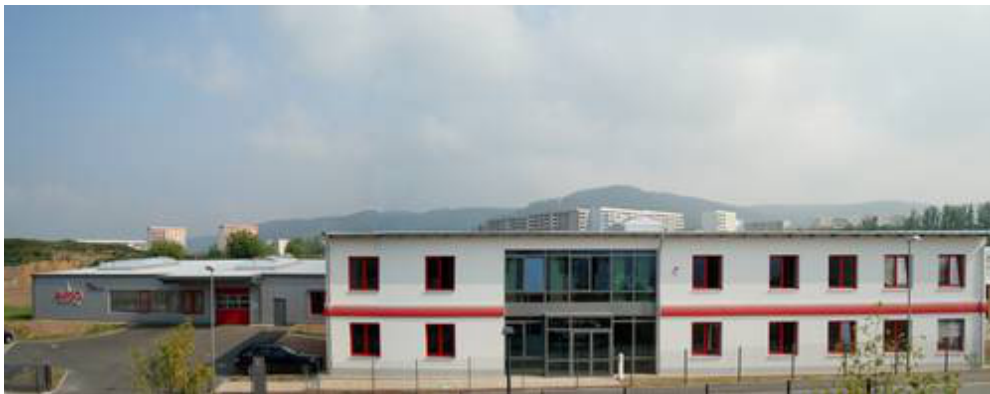
Hauptsitz der ALS Automated Lab Solutions GmbH am Standort Jena, Thüringen
